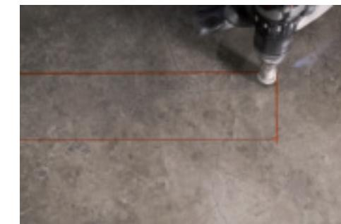
Per tagli a L o interni alla lastra si raccomanda la realizzazione di fori in corrispondenza dei vertici per evitare che la superficie si danneggi con la lama del flessibile.
