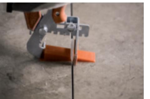
È necessario l'utilizzo di sistemi di livellatura per rendere perfetta la planarità della superficie posata.
